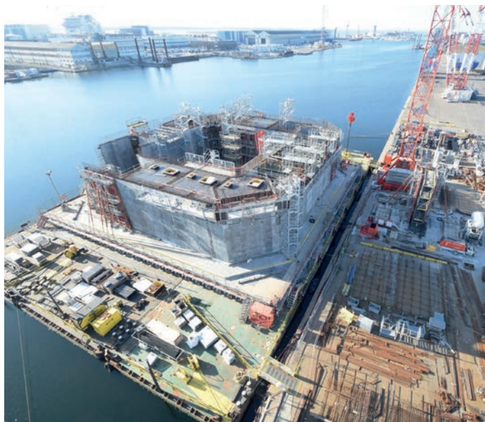
← La fondation flottante Ideol qui équipera l'éolienne Floatgen en construction sur le port de Saint-Nazaire (photo prise le 18 avril 2017).
