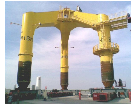
Tri-piles pour BARD I
